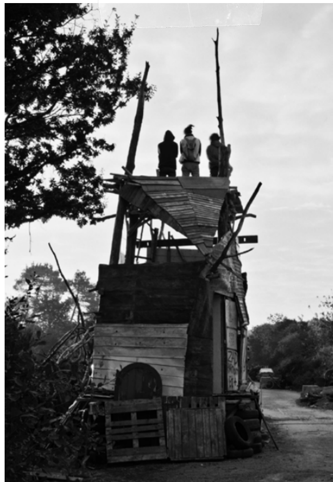
La tour de la ReINETTE en construction sur la D281.
